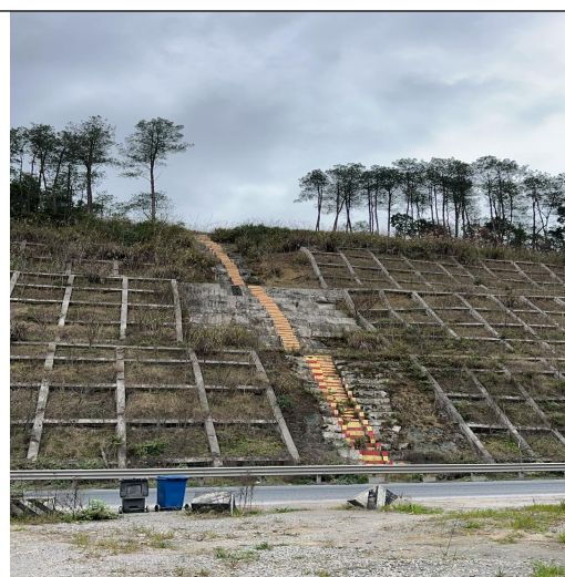
终点接入线路处施工迹地恢复情况
