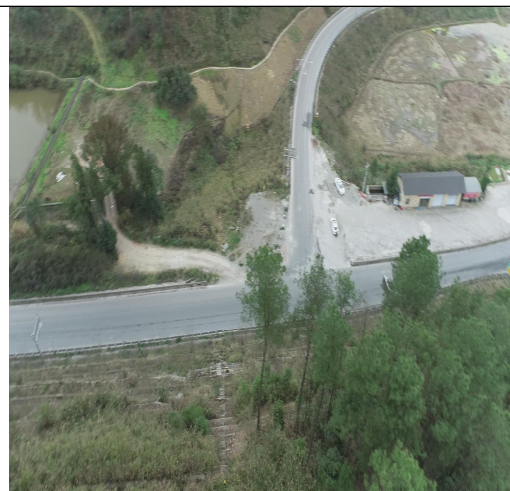
依托施工场地迹地恢复 1
