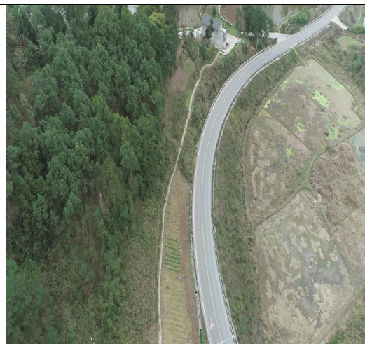
依托施工场地迹地恢复 1
