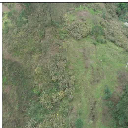
线路工程施工迹地恢复情况
