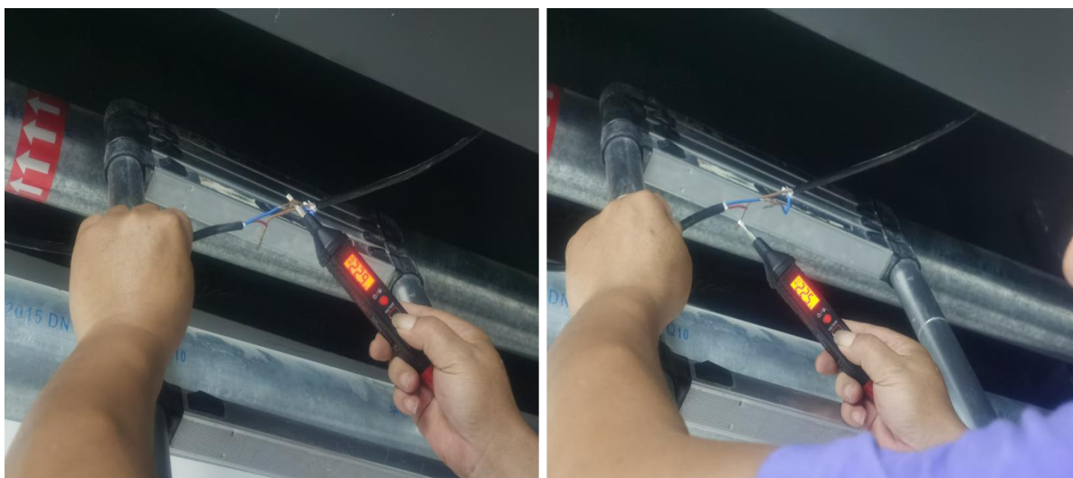
图5 汇聚箱内插线板单联开关断开时，监控线路电压测试情况
